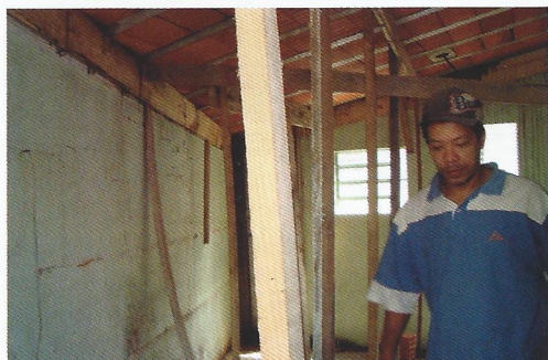
Consertos de telhados
